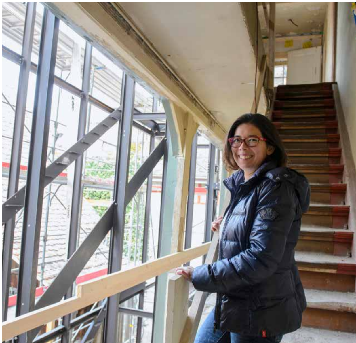
Die Pächterin der «Tanne», Claudine-Sachi Münger, auf der alten Treppe, die bald entfernt wird. Vor ihr ist das neue Stahlgerüst zu sehen, welches die Liftvorrichtung beinhalten wird. BILD SELWYN HOFFMANN
