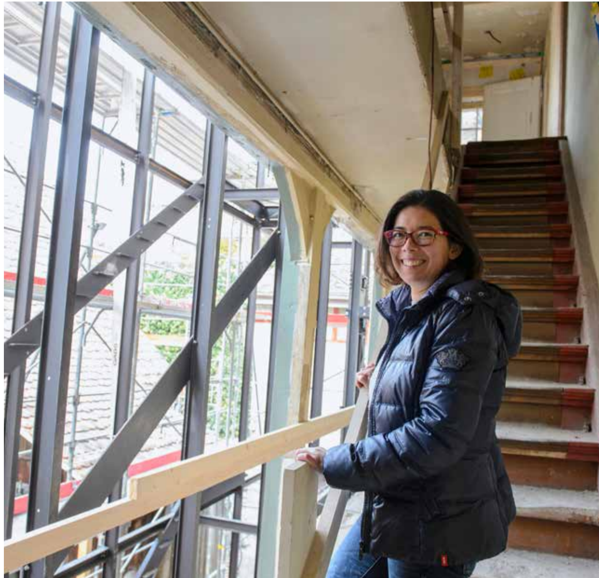
Die Pächterin der «Tanne», Claudine-Sachi Münger, auf der alten Treppe, die bald entfernt wird. Vor ihr ist das neue Stahlgerüst zu sehen, welches die Liftvorrichtung beinhalten wird. BILD SELWYN HOFFMANN
