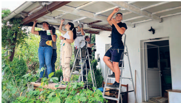
Streichen einer Terrasse von unten: eine der diesjährigen Arbeiten von Swiss for Greece
